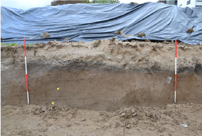
Fig. 5.7. Tiel-Fabriekslaantje. Noordflank of binnendijkse zijde van de laatmiddeleeuwse dijk. Zichtbaar in de foto is ook een van de waarschijnlijk laat 16de-eeuwse paalkuilen waarvan wordt vermoed dat het de sporen zijn van een houten redoute (vergelijk profiel WP2-P5 in figuur 5.4 (kaartbijlage)).
